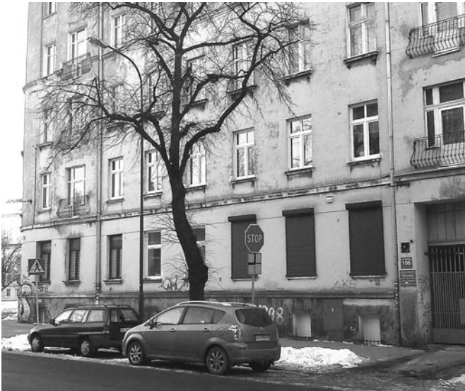
Ul. Gdańska 106 – pierwsza nieruchomość w Łodzi, do której doprowadzono kanalizację, rok 1927 – autor zdjęcia R. Podladowski
